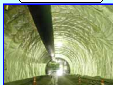
防水シート工
