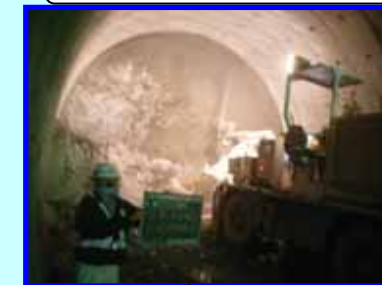
コンクリート吹き付け
