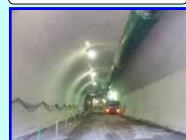
覆工コンクリート
