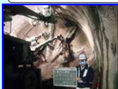
ロックボルト工
