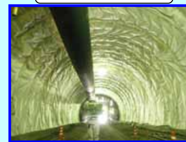
防水シート工
