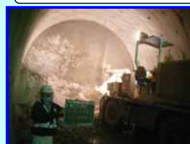
コンクリート吹き付け
