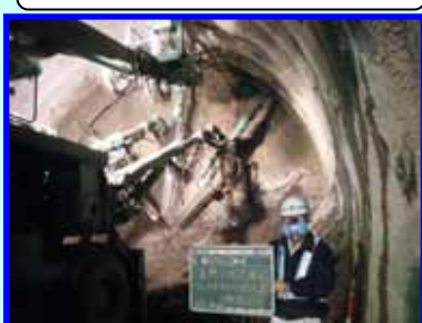
ロックボルト工
