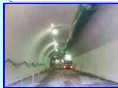
覆工コンクリート
