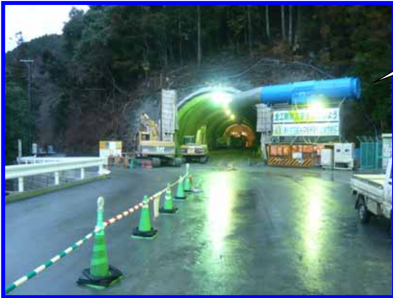
起点側 坑口付近
